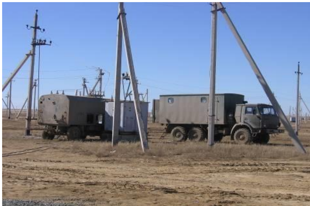
Рисунок 1. Размещение оборудования на промысле
